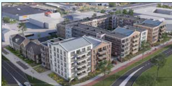
Westerdreefkwartier in aanbouw
