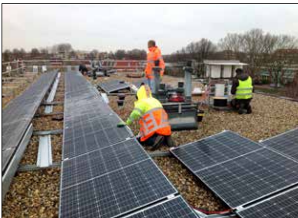
De zonnepanelen worden geplaatst.
